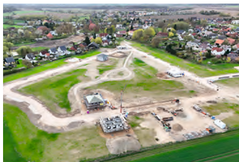
Wiesengrund im Bau
